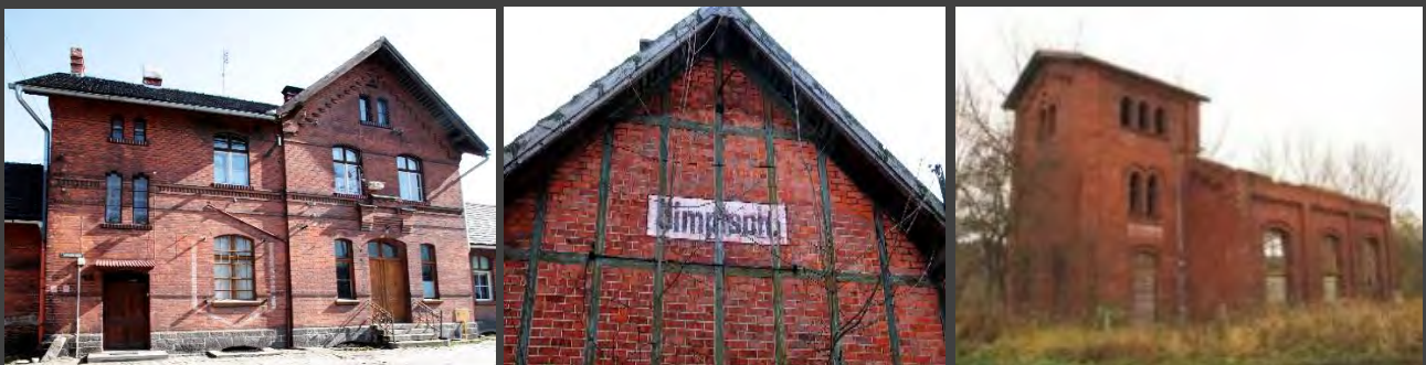
Stacja kolejowa i parowozownia kolei wąskotorowej w Niemczy
